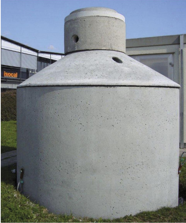
10 m 3 su hacmine sahip buz depolama tankı ve tank içerisindeki ısı çekme / rejenerasyon ısı deęiřtiricileri
